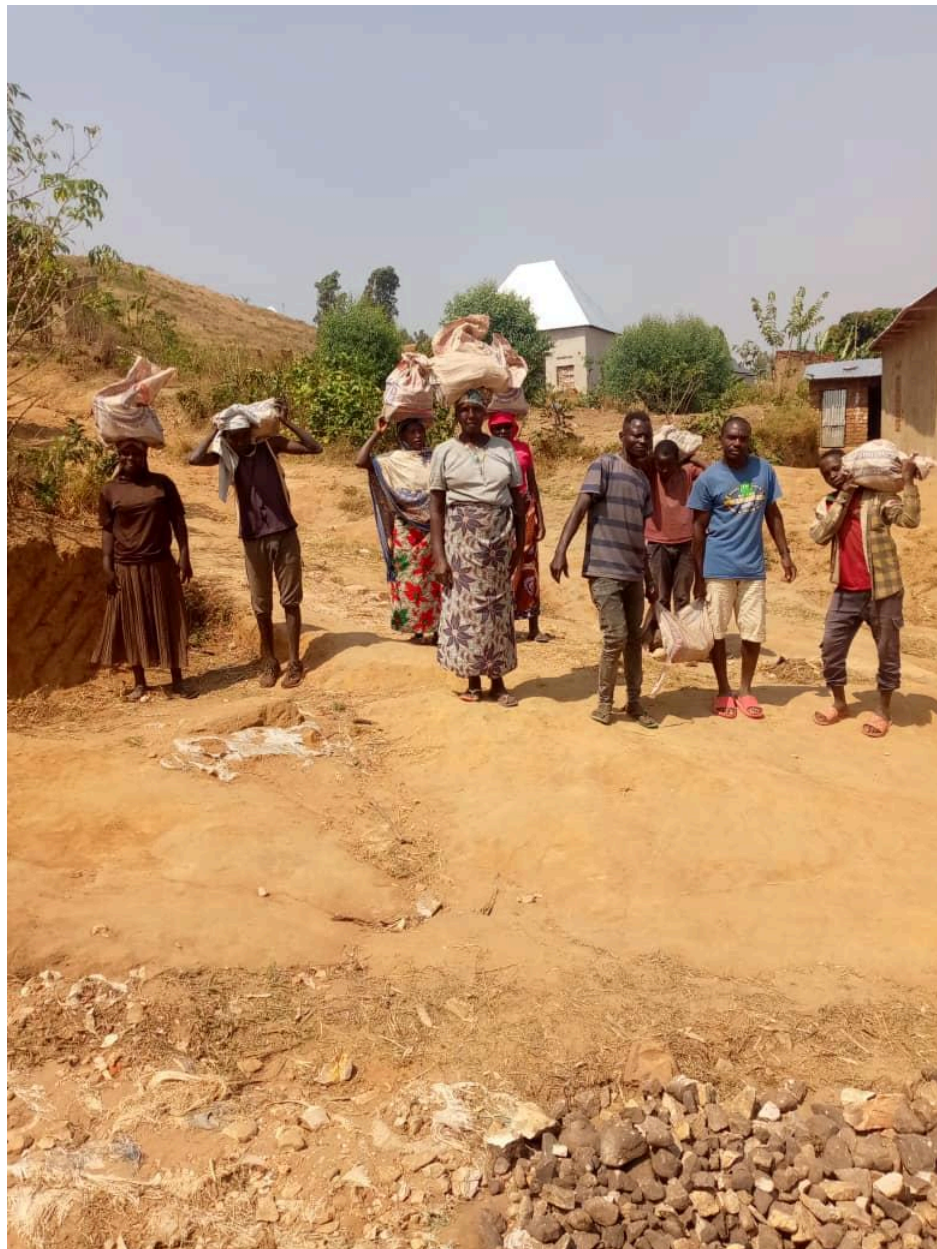
Uomini e donne al lavoro per la costruzione del centro nutrizionale - Gitega
